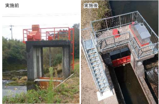
適正化事業実施前後写真 (伊佐市羽月頭首工)
