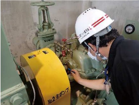
診断状況写真 (伊仙町河地揚水機場)
