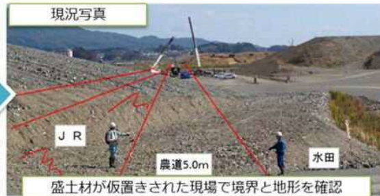
盛土材が仮置きされた現場で境界と地形を確認
