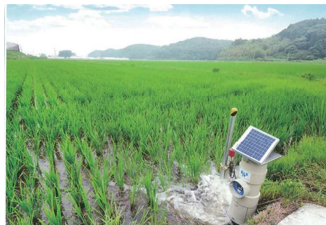
実証ほ場での試験施工
