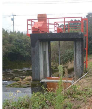
適正化事業実施前後写真 (伊佐市羽月頭首工)
