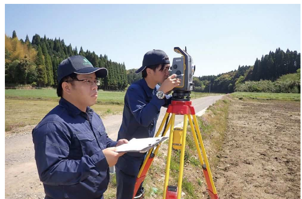
トータルステーションによる測量状況
