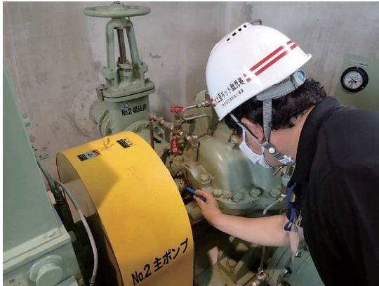
診断状況写真 (伊仙町河地揚水機場)
