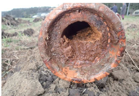
既設暗渠排水管の確認
