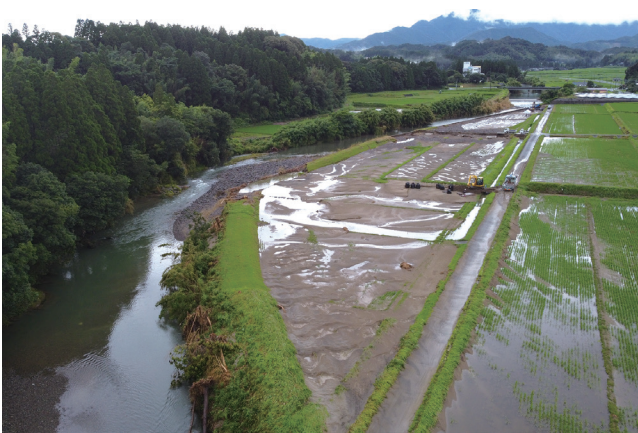
農地の被災状況写真 (さつま町)
