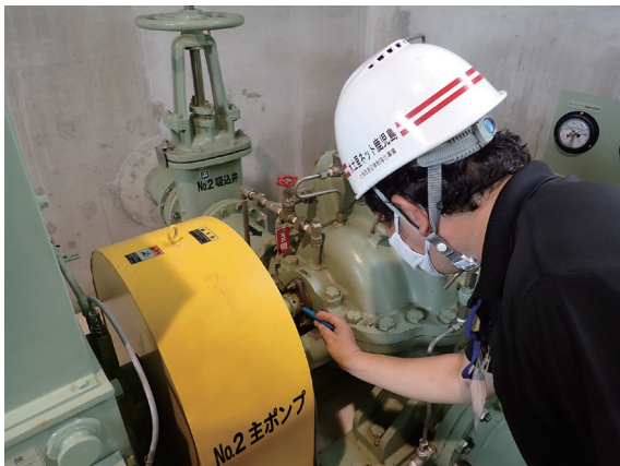
診断状況写真 (伊仙町河地揚水機場)
