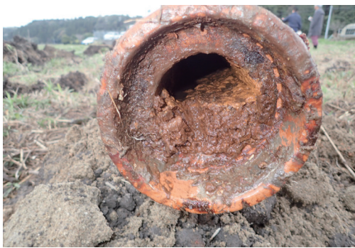
既設暗渠排水の確認
