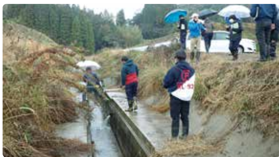
排水路の施工状況を確認する様子
