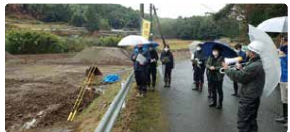
施工業者からの説明を受けている様子
