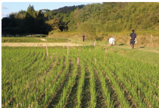
丁張り設置状況
