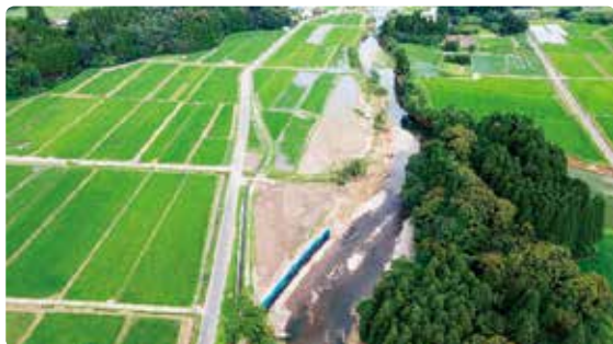
UAVによる被害状況の把握①
