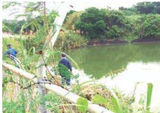
作業の様子（伊仙町伊仙池）
