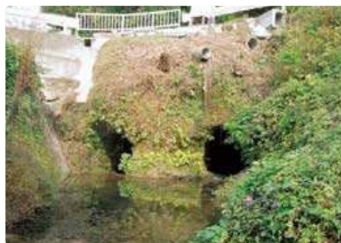
角之下川の隧道（素掘り）
