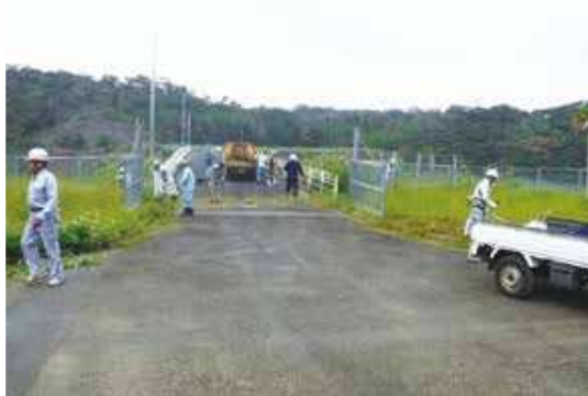
作業の様子（徳之島町神嶺ダム）
