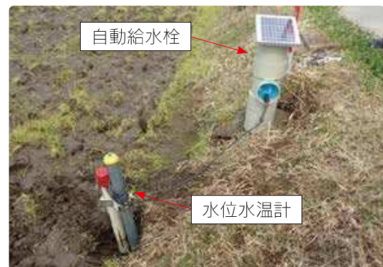
写真1：自動給水栓設置状況
