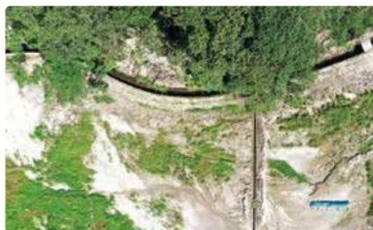
被災状況(ドローン撮影:真俯瞰)
