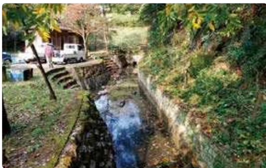
石積みの幹線用水路
