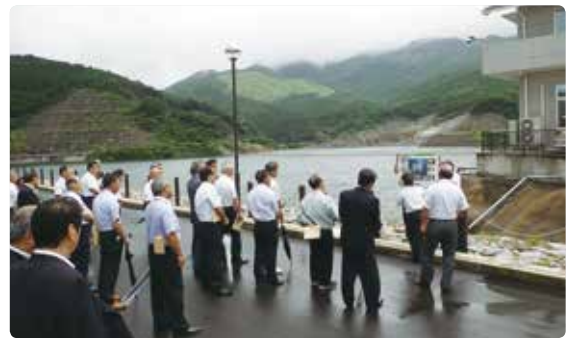
荒瀬ダム概要説明の様子
