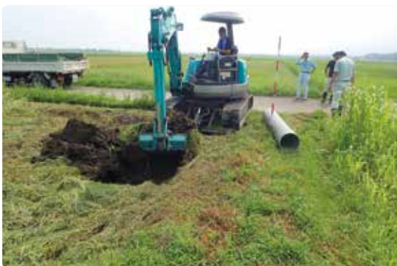
調査孔設置状況
