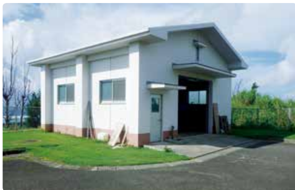
写真-2 移動式発電機格納庫
