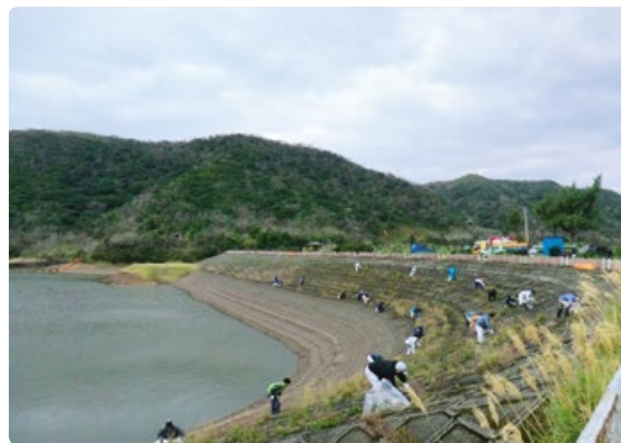
ダム堤体での作業状況
