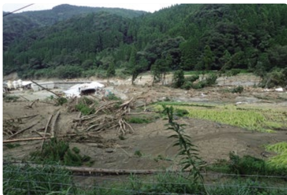
高隈ダム上流の被災状況
