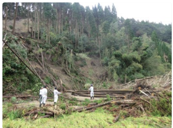
山林(ほ場背面)の崩壊
