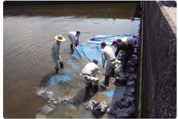
横山ファームポンドの応急処置を行う様子
