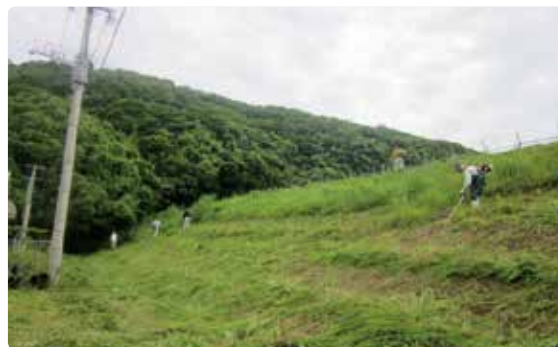
堤体の清掃作業
