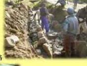
近隣国道の拡幅工事で発生した石を石積護岸水路の材料として使用
