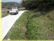
大雨による増水で、水路の生き物は河川に流下する。また、水路に隣接する農道法面も雨の度に洗掘されていた
