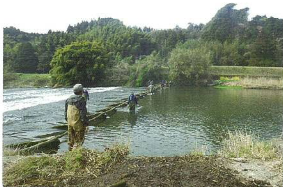
柴掛け前の川原園井堰全景
