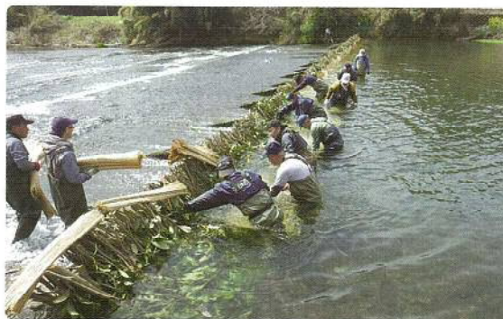
柴掛けの作業状況
