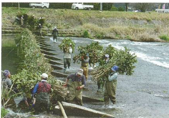
諏訪園 保「柴井堰の掛け替え」 川原園井堰(鹿屋市)
