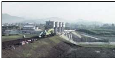
建設中のルイゴーン頭首工
