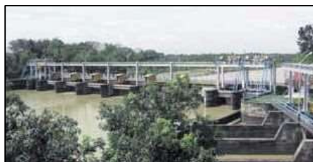
ルンタン頭首工
