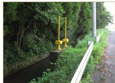
現在の放水門は手動式のスライドゲートであり、洪水時には管理者の危険が伴う操作となるばかりでなく、経年劣化により迅速な対応が困難な状況となっております。用排水路から洪水が発生した場合、農地への被害だけでなく市道など公共施設、民家への被害が想定されます。
