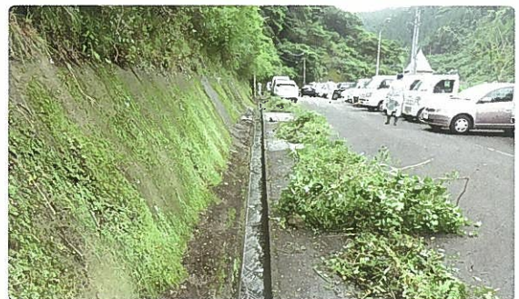
管理用道路の清掃
