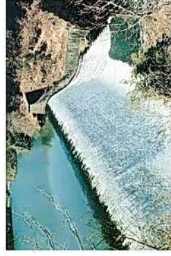
富士緒井路の水源 白水ダム
