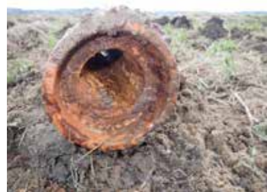
既設暗渠の確認
