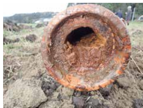
土管：施工後15年経過
