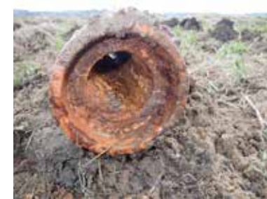
既設暗渠の確認
