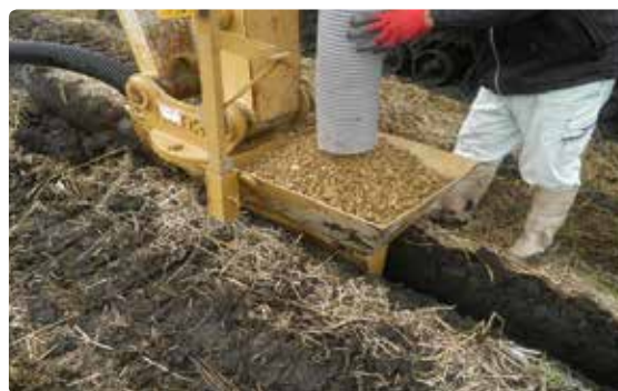
疎水材（ボラ）投入状況
