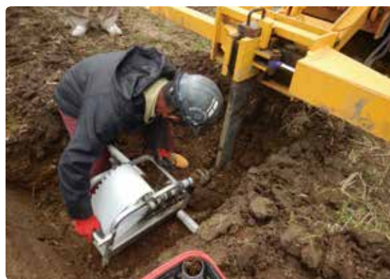
シートパイプ施工状況②
