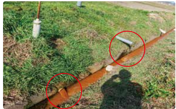
補助暗渠施工直後の既設水閘の状況（左）と 地下かんがい水閘からの排水状況（右）
