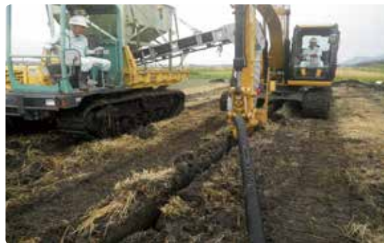
有孔管布設（疎水材同時埋設）
