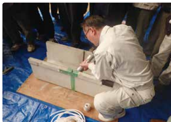
補修の実技研修の様子
