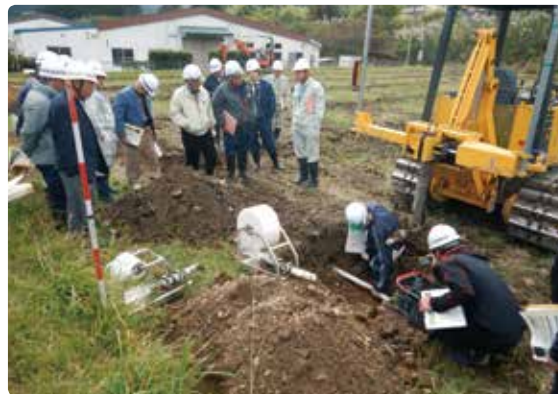
シートパイプ施工状況①
