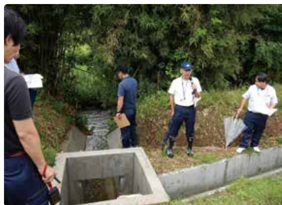
河川協議についての説明（横伏敷団地）
