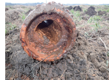
既設暗渠の確認
