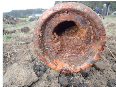
土管：施工後15年経過
