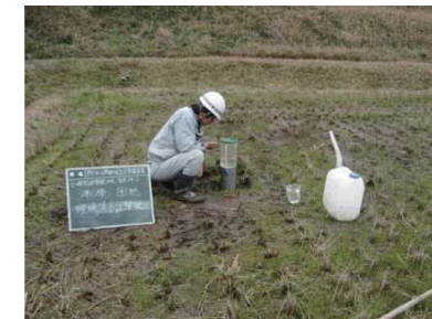
現場透水試験
